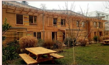
Les Communs d'abord seront installés juste à côté des Castors, qui a été le tout premier (et qui reste le seul à ce jour) programme d'habitat participatif à Saint-Étienne. Photo Progrès/Loïc TODESCO
